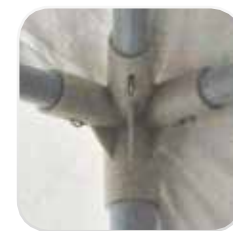
Unión estructural: Esquina
